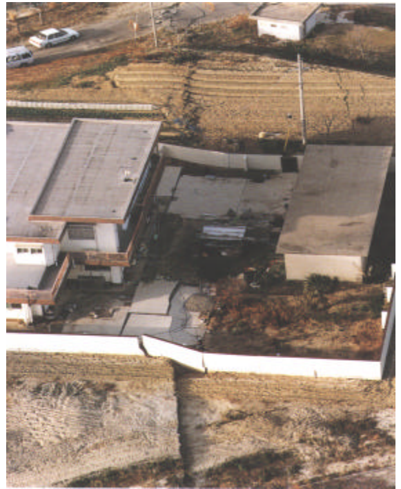
图 2 1995 年日本阪神地震断层地表破裂带 小仓断错点地面建筑设施破坏实例
