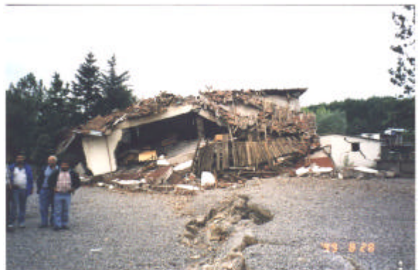
图 3 土耳其伊兹米特地震地表破裂带（地震断层） 与地面建筑物破坏实例
