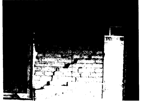
图2 墙体“八”字型裂缝
