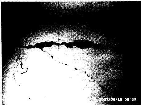
图5 墙体水平裂缝
