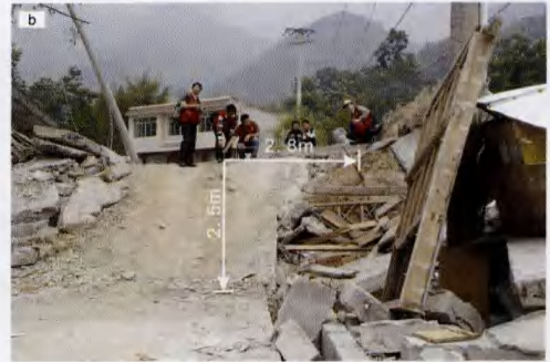
(b) 贵溪乡凤凰村五队地震断层陡坎和公路右旋水平位移错
