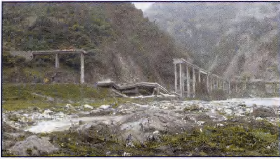
照片 1 百花大桥 Photo 1 Baihua bridge
