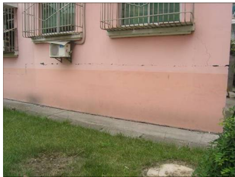
图1 汶川地震中绵竹某砌体结构房屋的底部水平裂缝(李爱群提供)
