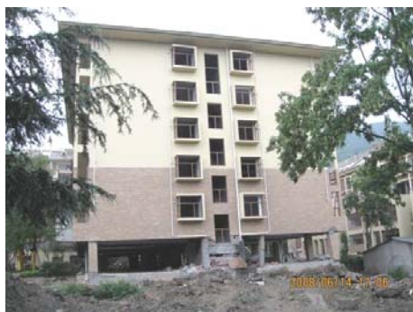
(a) 建筑全景
