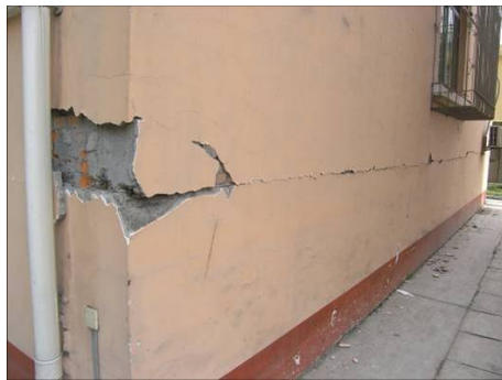
图1 汶川地震中绵竹某砌体结构房屋的底部水平裂缝(李爱群提供)
