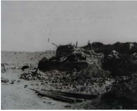
照片 5 1954 年山丹地震大湖房屋倒塌现象 (据柏自兴, 1954)
