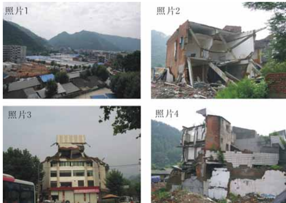
照片 1 沿平武-青川主干断裂一线的房屋破坏总貌, 倒塌房屋多已拆除, 改建为板房区 (镜向 E); 照片 2、3、4 为平武-青川主干断裂通过位置典型房屋破坏照片 (镜像依次为: N、W、E)
