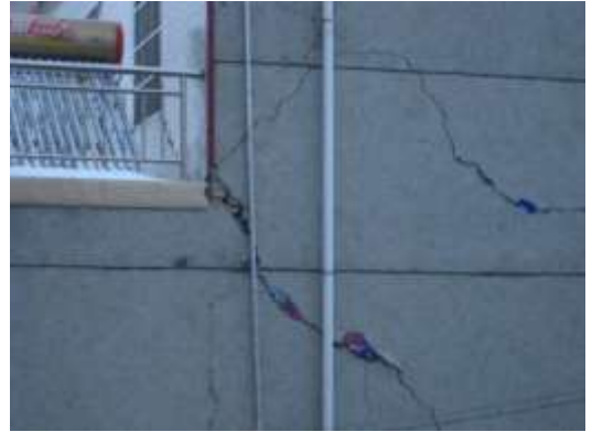
(b) 2005 年修建房屋的外部破坏图
