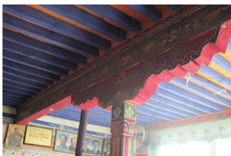
图 13 梁柱连接
