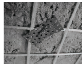
图 4 打包带拉结
