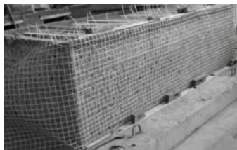
图 3 墙体打包带加固
