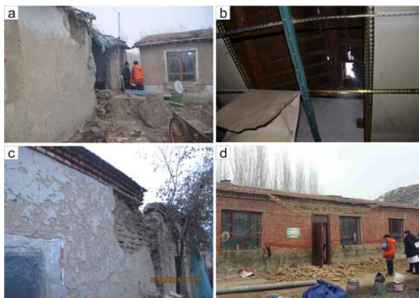
(a) 雀尔沟镇雀尔沟村三片区民房；(b) 雀尔沟镇雀尔沟村一片区民房； (c) 雀尔沟镇民房；(d) 雀尔沟镇西沟村二片区民房（典型砖包皮土坯房）
