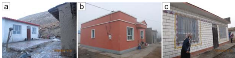
(a) 雀尔沟镇（左侧为安居富民房屋，完好未出现破坏；右侧为老旧土木结构房屋，前纵墙前倾山墙开裂，屋内承重墙体多数开裂）；
