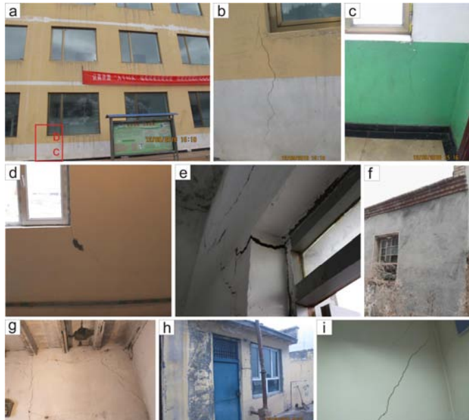
(a) 丰源煤矿生产调度办公楼（三层砖混结构）；(b)、(c) 为图(a)同一窗角屋外及屋内照片；
