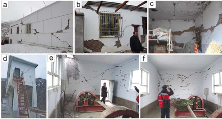
(a)、(b)、(c) 西沟变电站办公楼（雀儿沟镇雀尔沟村三片区附近）；(d)、(e)、(f) 塔西河石门子水库闸井室
