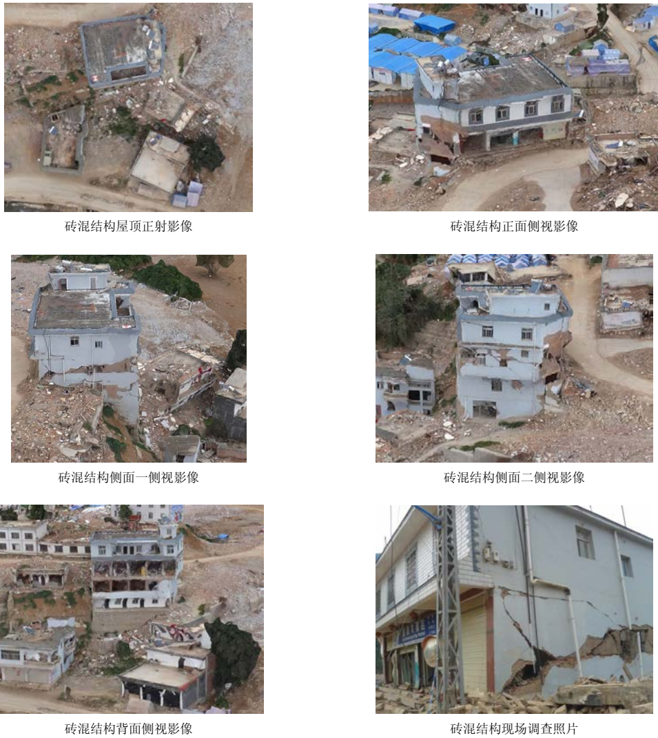
图 3 龙泉村砖混结构示例
