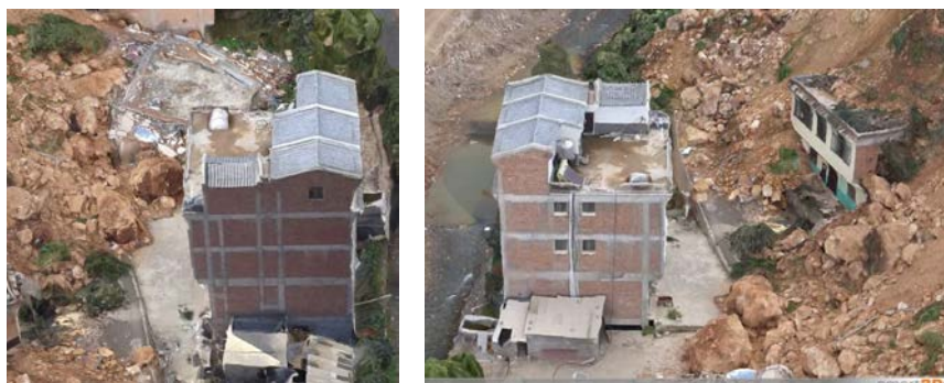
图 7 滑坡掩埋房屋、滚石击中房屋（放大）
