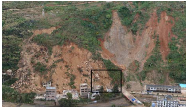
图 4 滑坡、滚石（正面）
