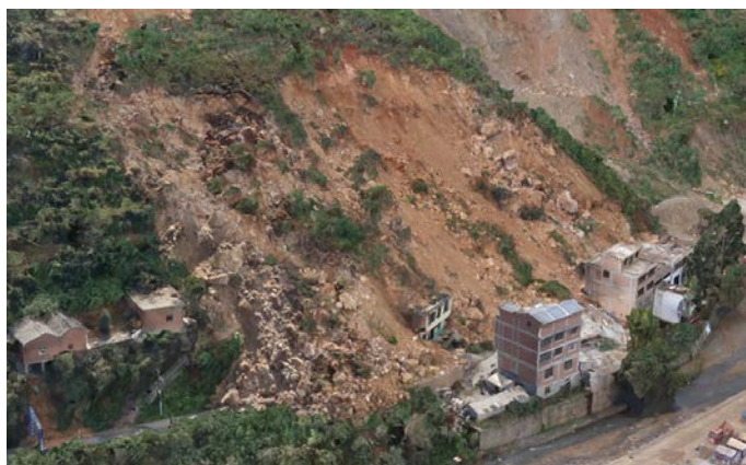
图 6 从另一角度展示滚石击中房屋，滑坡土方掩埋房屋
