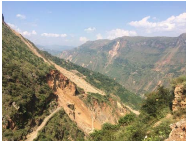
图 10 图 8 滑坡的现场考察照片
