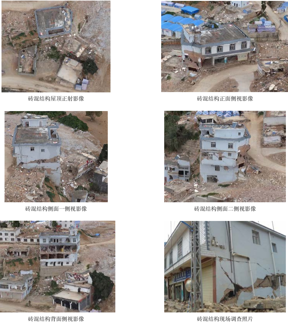
图 3 龙泉村砖混结构示例
