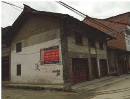
(a) 土坯墙结构
