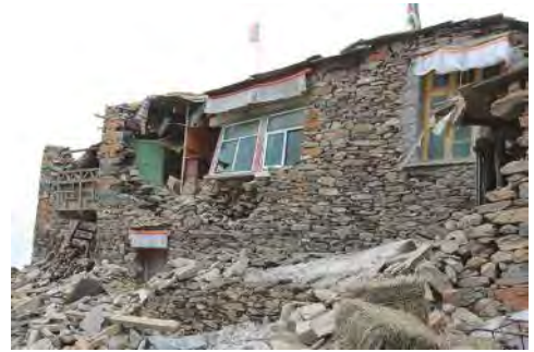
图 2 石木结构破坏
