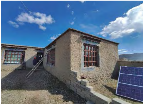
图3 典型土木房屋
